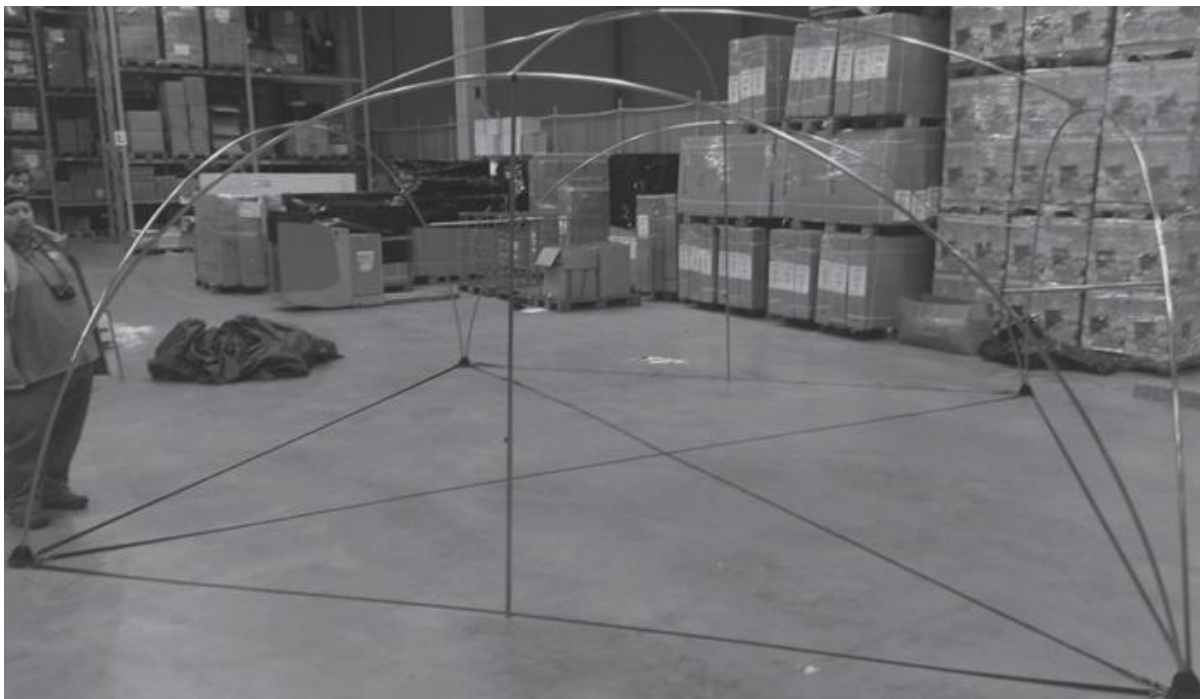
12) Teraz celá konštrukcia stojí
